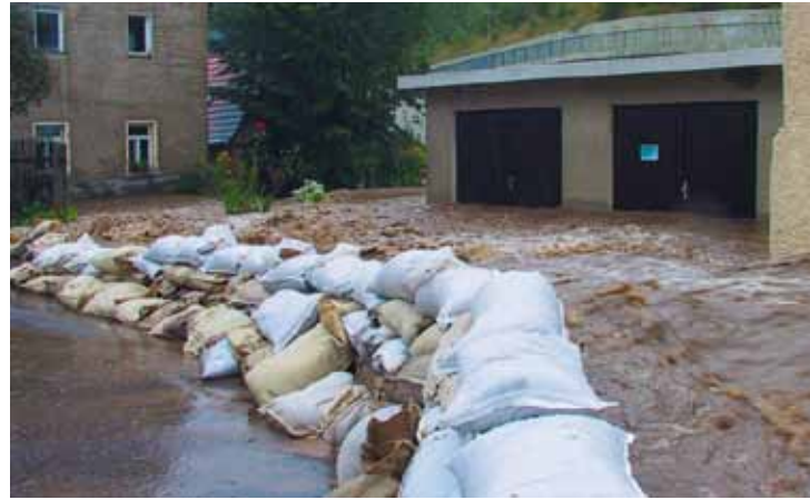
Ein Sandsackwall kann bereits sehr wirkungsvoll sein.
