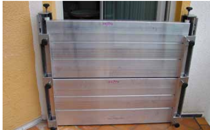
Objektschutz an Gebäudeöffnungen
